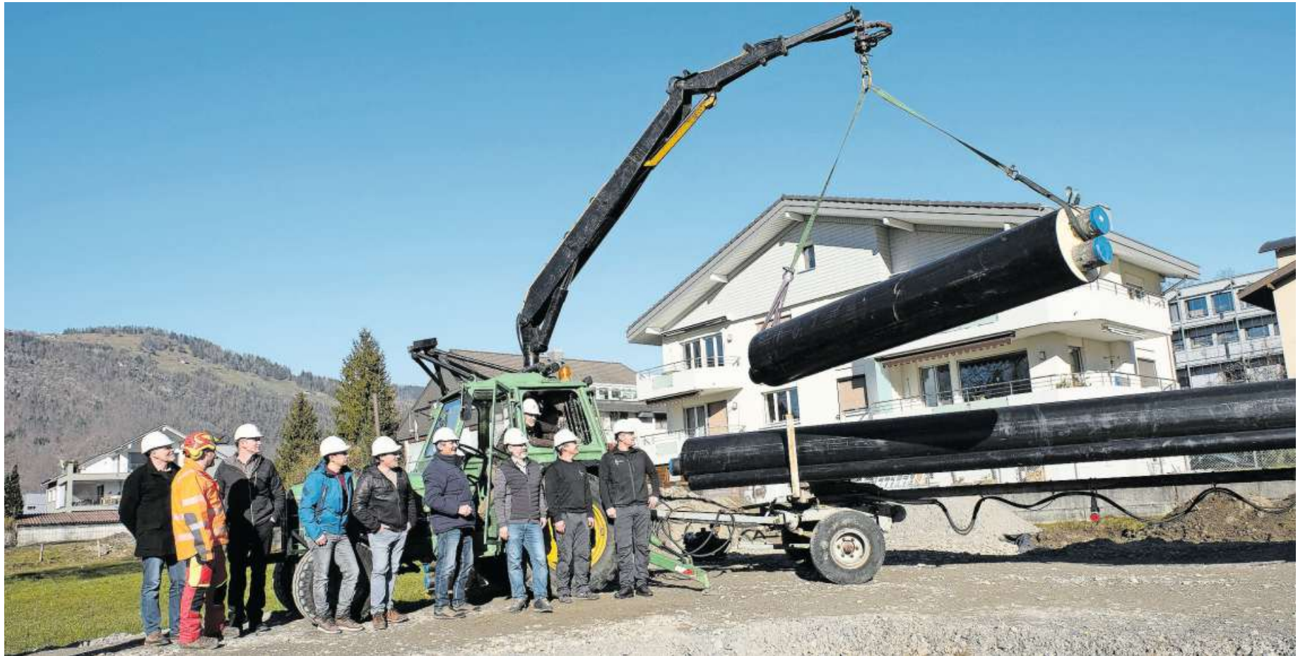
Der symbolische Spatenstich. Durch diese Rohre fliesst das Heizwasser mit einer Temperatur von zirka 80 Grad.
