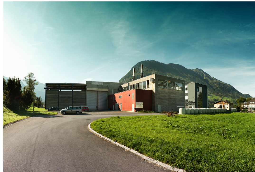
Die Zentrale: Sämtliche Heizwärme entsteht in der Verbrennungsanlage in Oberdorf.
