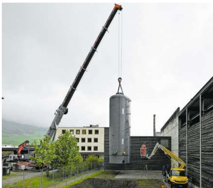
Die zwei Wärmespeicher mussten mit einem mobilen Grosskran versetzt werden.
